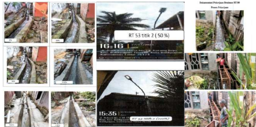
Gambar 3. 10 Kegiatan Pembangunan Fisik Sarana dan Prasarana Kelurahan
