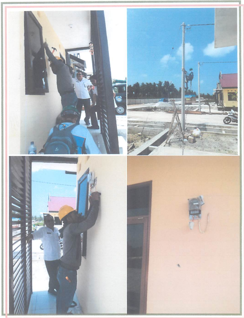
Gambar 3.10 (Lanjutan) Pemasangan Listrik (PLN) di SIKT
