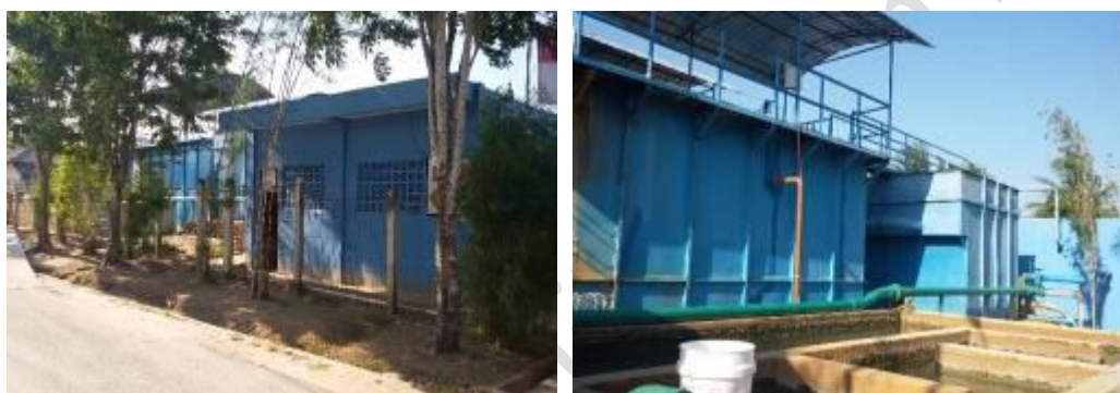
Gambar 3.22. Instalasi Pengolahan Air Gunung Tembak
