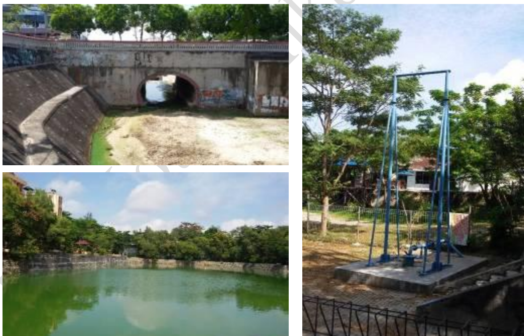
Gambar 3.21. Instalasi Pengolahan Air Gunung Sari
