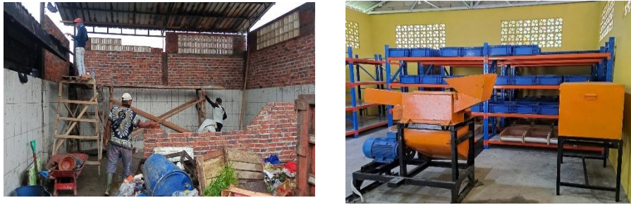
Gambar 3.8 Pembangunan dan perlengkapan TPST Rumah Magoot Sumber : Dokumentasi Kecamatan Balikpapan Kota
